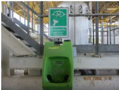
รูปที่ 2-6 อุปกรณ์ล้างตาฉุกเฉินและอุปกรณ์ล้างตัวฉุกเฉิน
