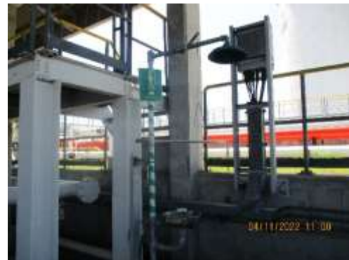
รูปที่ 2-6 อุปกรณ์ล้างตาฉุกเฉินและอุปกรณ์ล้างตัวฉุกเฉิน
