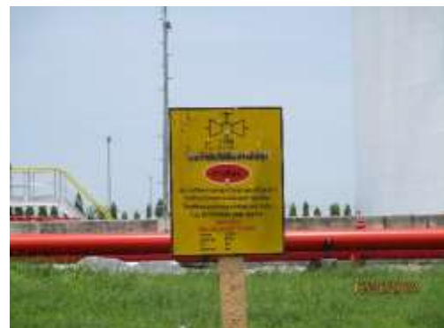
รูปที่ 2-12 การตรวจสอบและป้ายแสดงตำแหน่ง Block Valve
